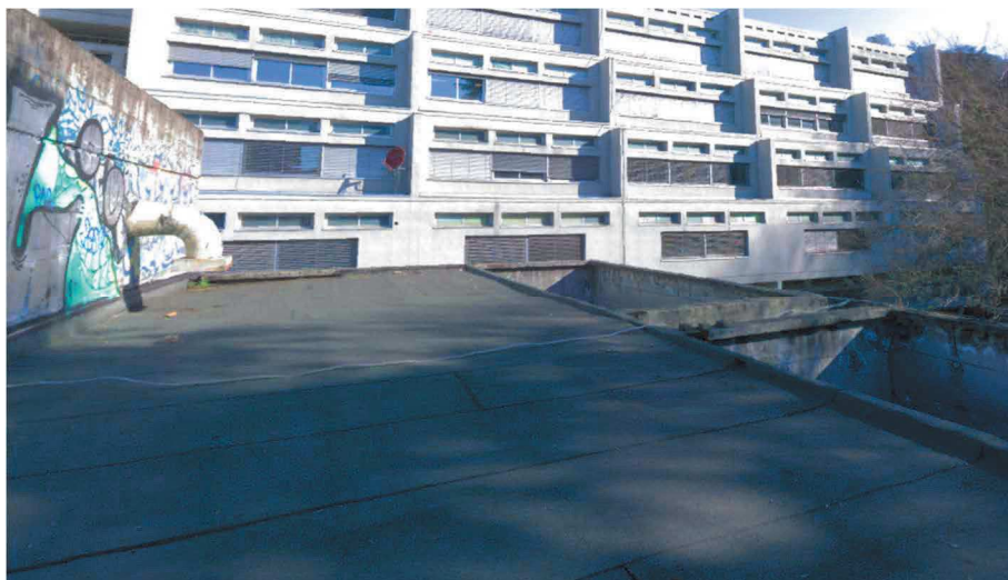
Dettaglio stato guaine copertura zona palco
