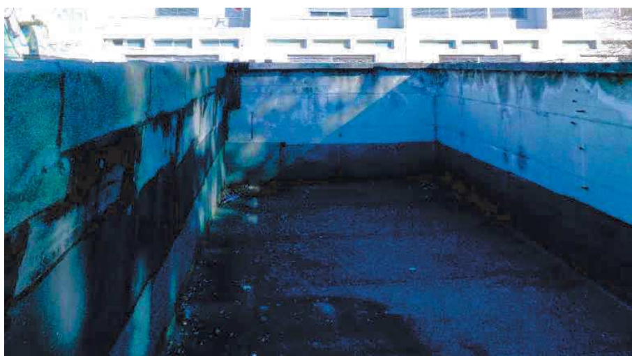
Dettaglio guaine copertura locali retro palco
