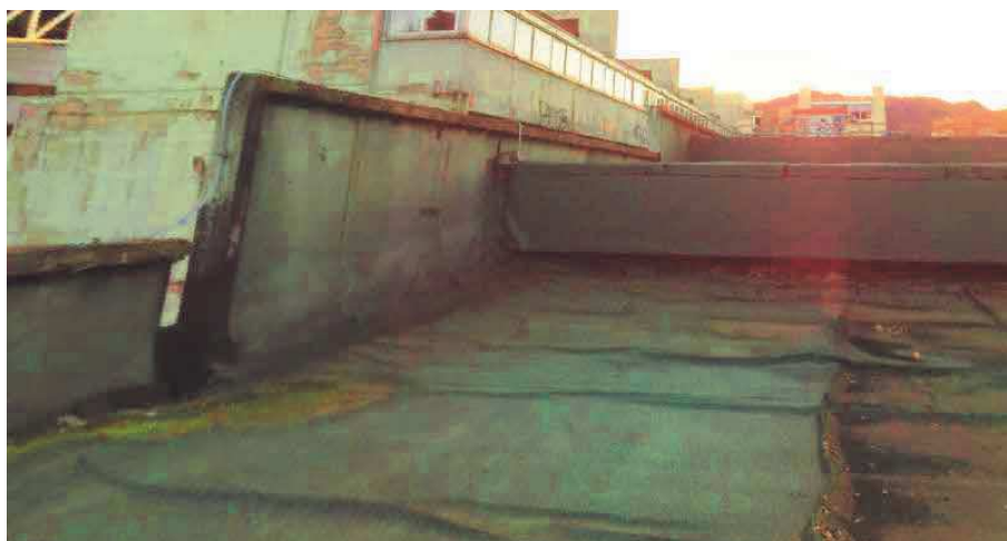
Dettaglio distacco guaina copertura
