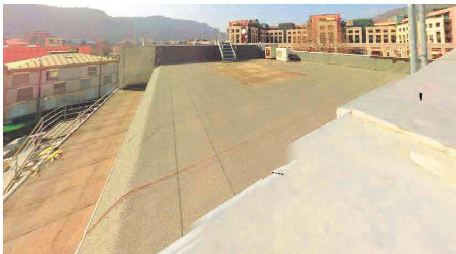
Dettaglio stato guaina copertura e corridoio piano terzo
